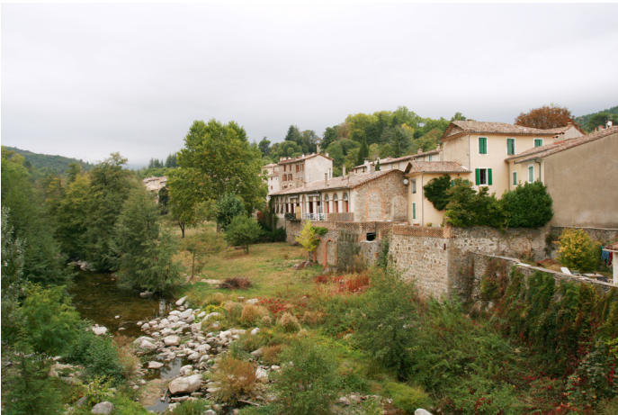
Lasalle - Façade du village aligné sur la rivière
